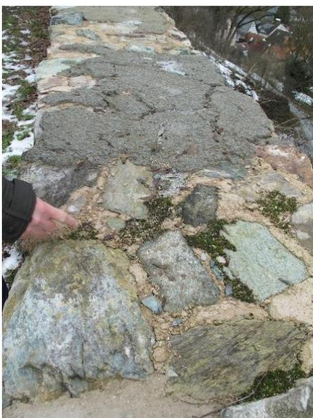
Abb. 17: Schäden im FL-Mörtel nach Standzeit über zwei Winter. Im Hintergrund die aufgebrauchten Substrate zur Ansiedlung der Moosbegrünung
