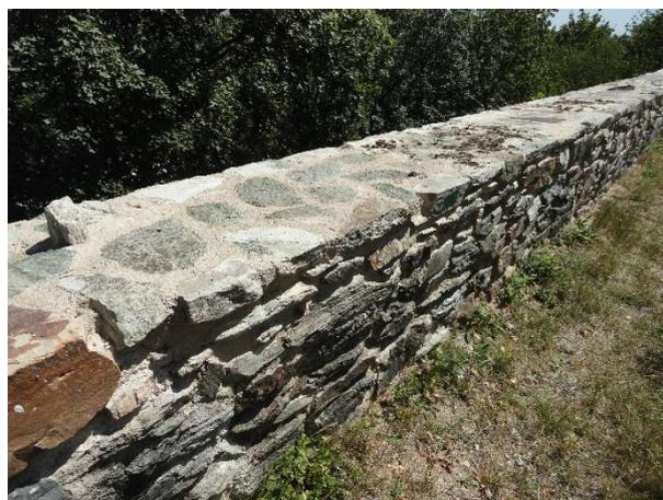
*Abb. 28: Abschließende Nachkontrolle im Juli 2020. Mauerkronenabschnitte mit TKF stehen auch nach zwei Jahren ohne nennenswerte Mängel da. (Der hochstehende Stein wurde bewusst als Markierung so verbaut.)*
