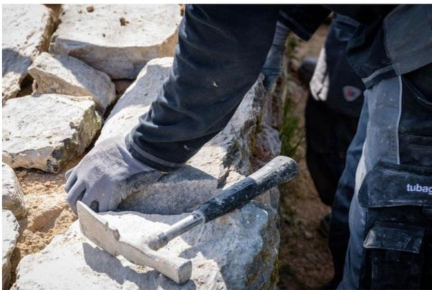
Abb. 15: Wiederanlegung der Musterfläche diesmal mit TKF, große Steinformate bilden den randlichen Mauerkronenabschluss
