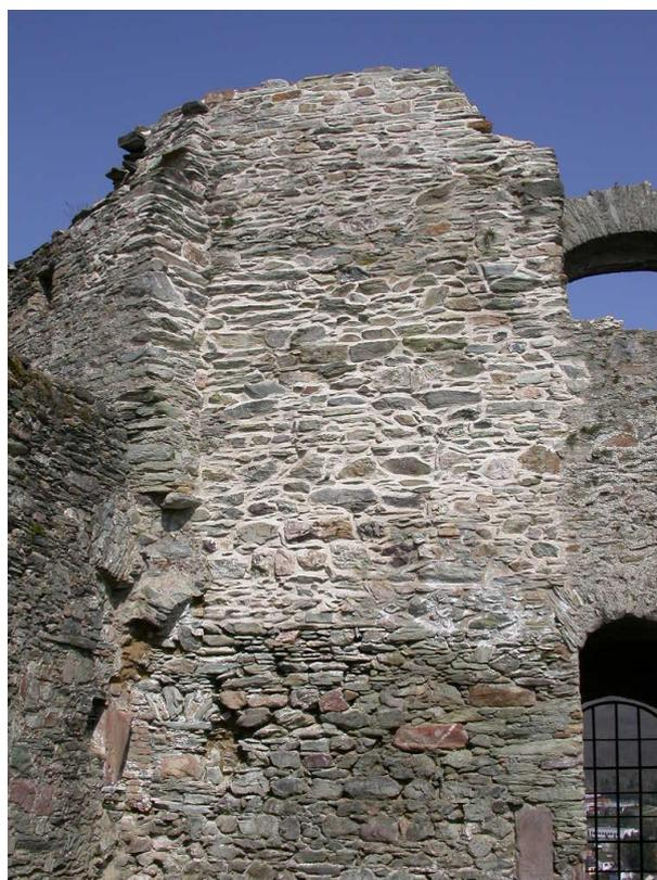
Abb. 5: Partielle und auf die historische Kalksubstanz abgestimmte Reparatur des Mauerwerks mit einem NHL-Mörtel.
