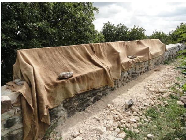
*Abb. 27: Zeltartig aufgebrachte Jutebahnen zwecks Verschattung und Feuchthaltung der frisch sanierten Mauerkrone.*
