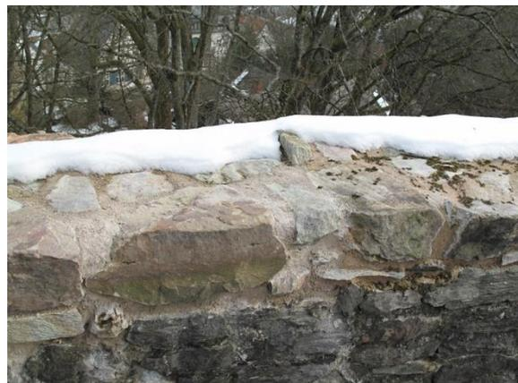
Abb. 14: Direkter Vergleich der Musterflächen mit TKF (links) und FL (rechts) mit intakter Verfugung; der hochkant eingebaute Stein dient als Begrenzungspunkt (Foto: Burgenbüro Dr. Strickhausen).
