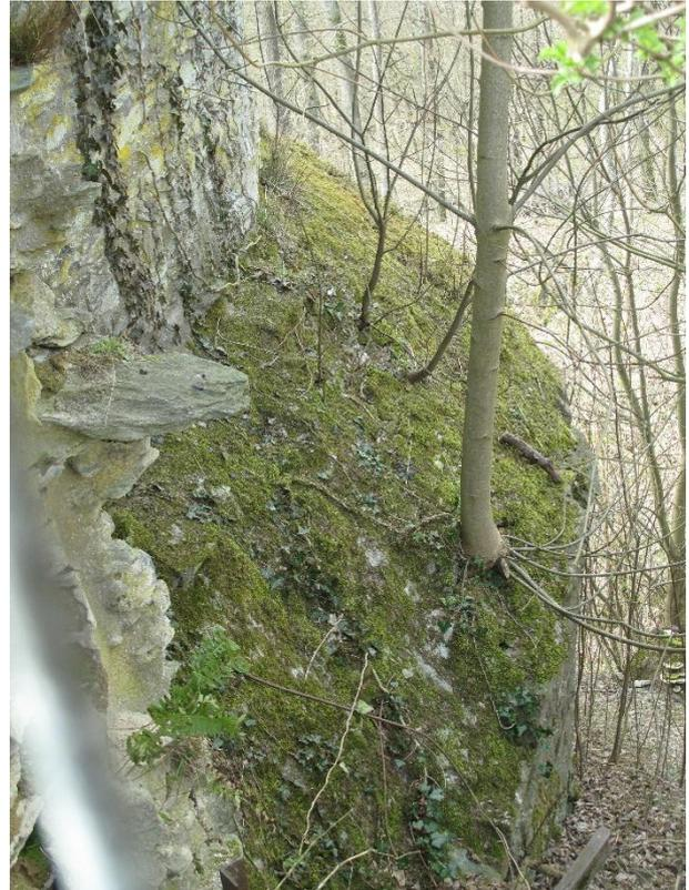
Abb. 7: Burg Königstein, Pulverturm mit Gehölzen im Mauerwerk,
