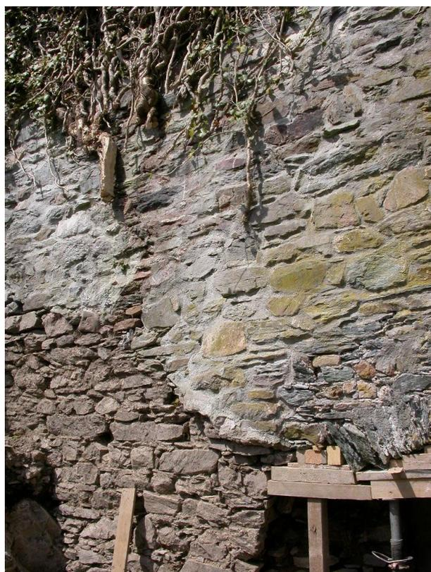
Abb. 4: Sanierungen mit hochhydraulischen Mörtelsystemen aus der jüngeren Vergangenheit. Die dichten, überfesten Anstragungen führen regelmäßig zu Folgeschäden.
