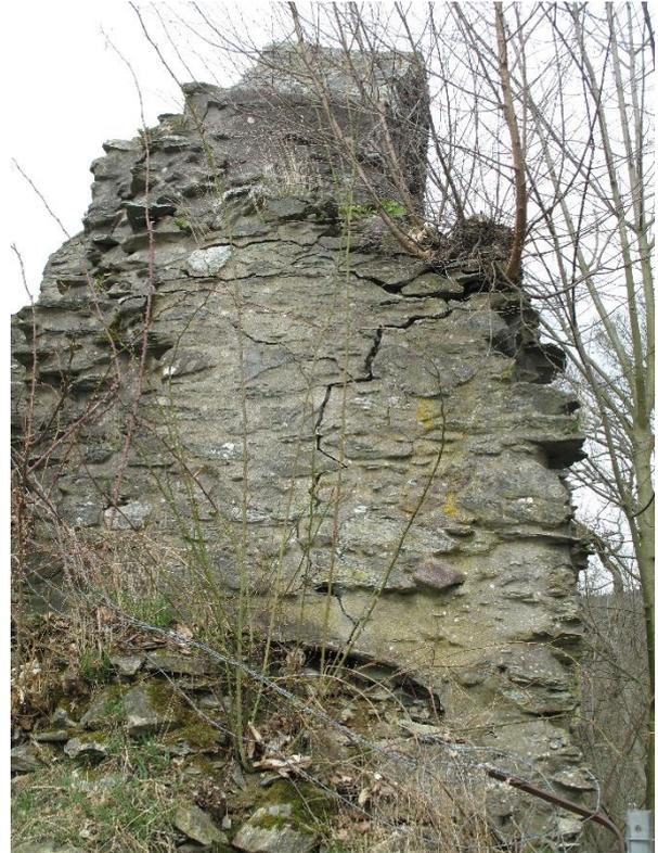
Abb. 8: Burg Königstein, Pulverturm mit Schäden durch eine Birke auf der Mauerkrone, Foto: Burgenbüro Dr. Strickhausen Nov. 2017.
