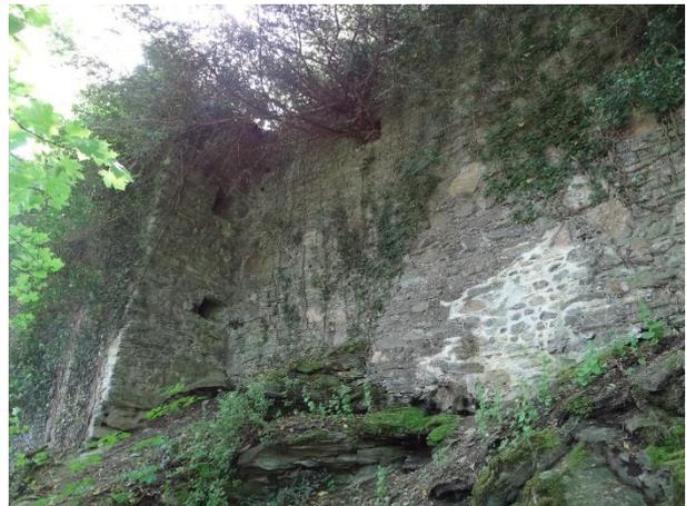
Abb. 3: Stark verholzte Mauerbereiche an der Nordflanke (Bildarchiv LfDH 2018).
