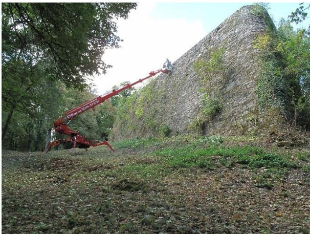
*Abb. 22: Burg Königstein, Hubsteigereinsatz an der Spitzen Bastion, die dicht mit verholzendem Bewuchs und im Mauerwerk wurzelndem Efeu bewachsen war. Der Hubsteiger ermöglicht hier zwei Personen gleichzeitig ein sicheres, effektives Arbeiten auch bei starken Gehölzen,
