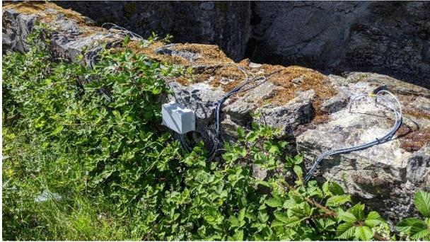
Abb. 19: Darstellung der Mauerkrone im Bereich des Messaufbaus im Mai 2020, es ist ein deutlicher Bewuchs durch eine Brombeerhecke festzustellen.
