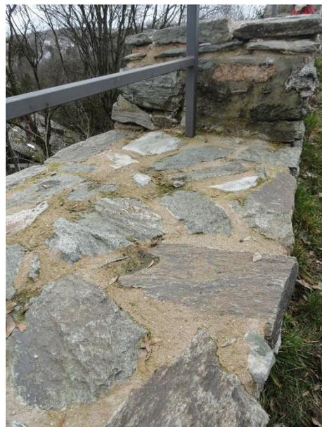
Abb. 24: Pfützenbildung verdeutlicht sich gut durch die einsetzende Vergrünung, am oft mangelhaften Kontakt von Mörtel zum Stein entstehen Risse, in die Feuchte eindringen und Vergrünung ansetzen kann.
