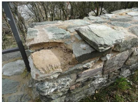
Abb. 23: Durch die mangelhafte Unterfütterung und gleichzeitige Ausbildung einer glatten Kontaktfläche im Mörtelbett (mit Sinterhaut, bedingt durch Wasserhäutchen) verliert der Eckstein schnell den Verbund zum Mauerwerk und löst sich ab.
