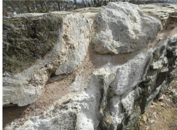
Abb. 22: Infolge Bindemittelauswaschung kommt es zu seitlich hinablaufenden Kalksinterungen („Tropfsteine“), TKF-Musterfläche.
