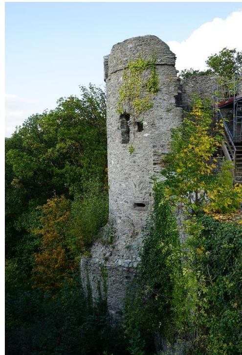
Abb. 13: Burg Königstein, der Pulverturm wurde im Nov. 2017 nicht vollständig vom Efeu befreit. Trotz der extrem trockenen Sommer 2018 und 2019 wächst der Efeu im Okt. 2019 weiter im Mauerwerk, Fotos: Burgenbüro Dr. Strickhausen.
