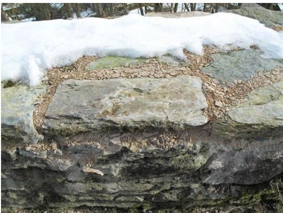
Abb. 13: NHL-Musterfläche mit aufgefrorener Verfugung im sanierten Kronenbereich.
