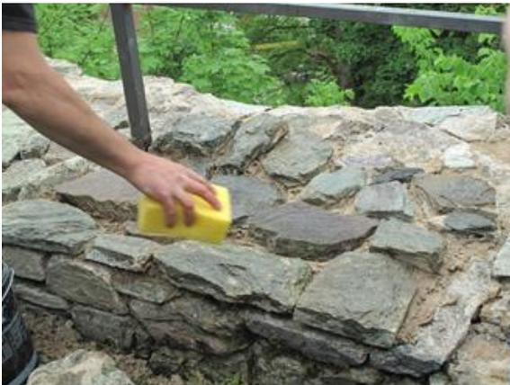
Abb. 11: Verfugarbeiten an der frisch aufgesetzten Mauerkrone (Foto: Burgenbüro Dr. Strickhausen).
