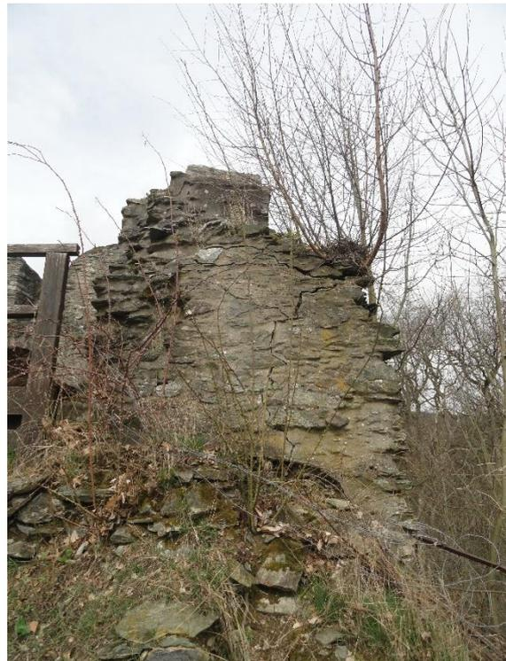
Abb. 1: Stark überwachsene und verstürzte Mauerreste am Pulverturm innerhalb der Burganlage Königstein.
