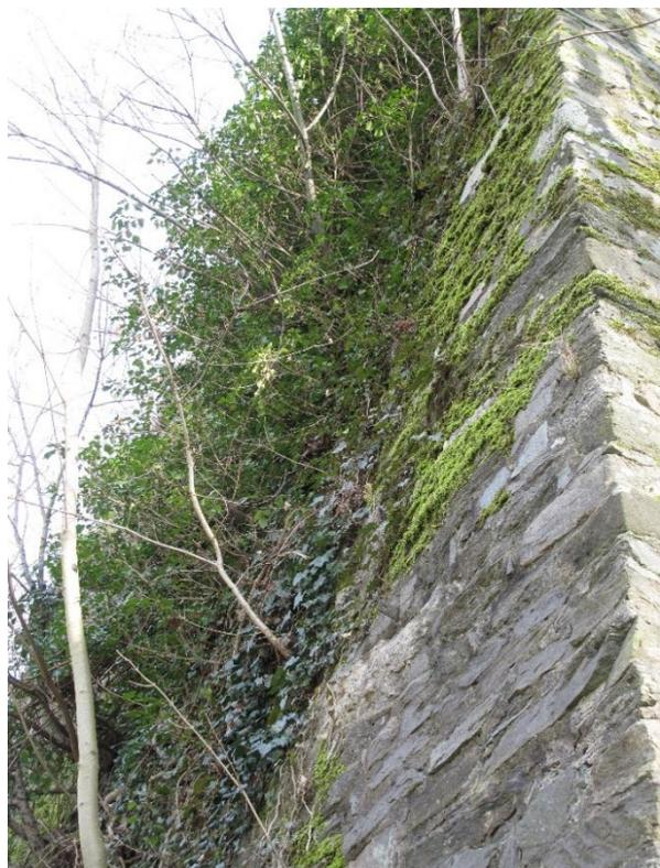
Abb. 10: Burg Königstein, Neue Bastion mit dichtem Bestand an verholztem Bewuchs und Efeu, der in den Mauern wurzelt,
