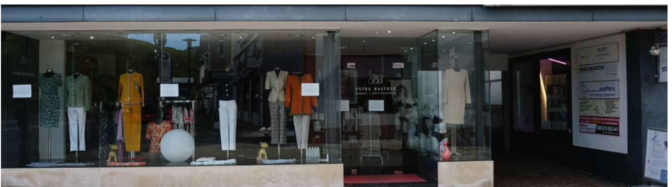
Gestörte Fassade, fehlende Untergliederung
