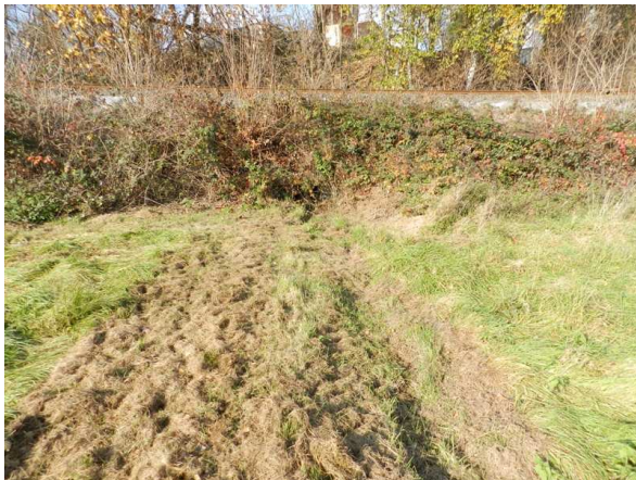
Foto 13: Trockene Grabenmulde ohne Wasserführung an einem gemauerten Bahndurchlass im Nov. 2011.
